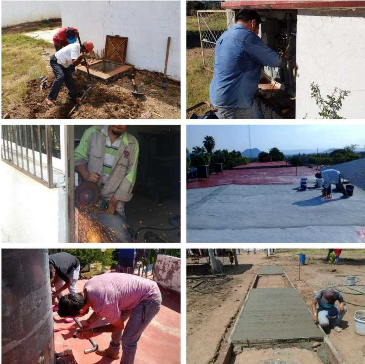
Figura 8. Mantenimiento a Equipo e Infraestructura.
